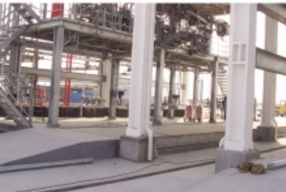
注: 现场图片(槽车秤: 称体镀锌 + 配秤控制 + Zone 1 区防爆)
